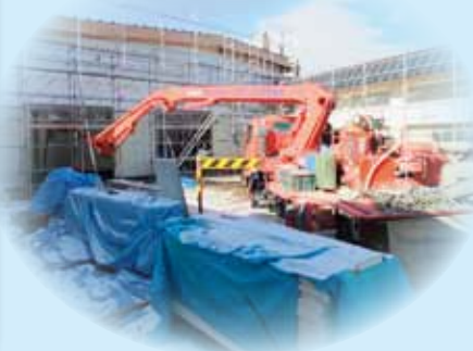
クレーン工事
